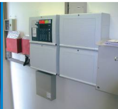
oben links: Vernetzte Brandmeldezentrale
