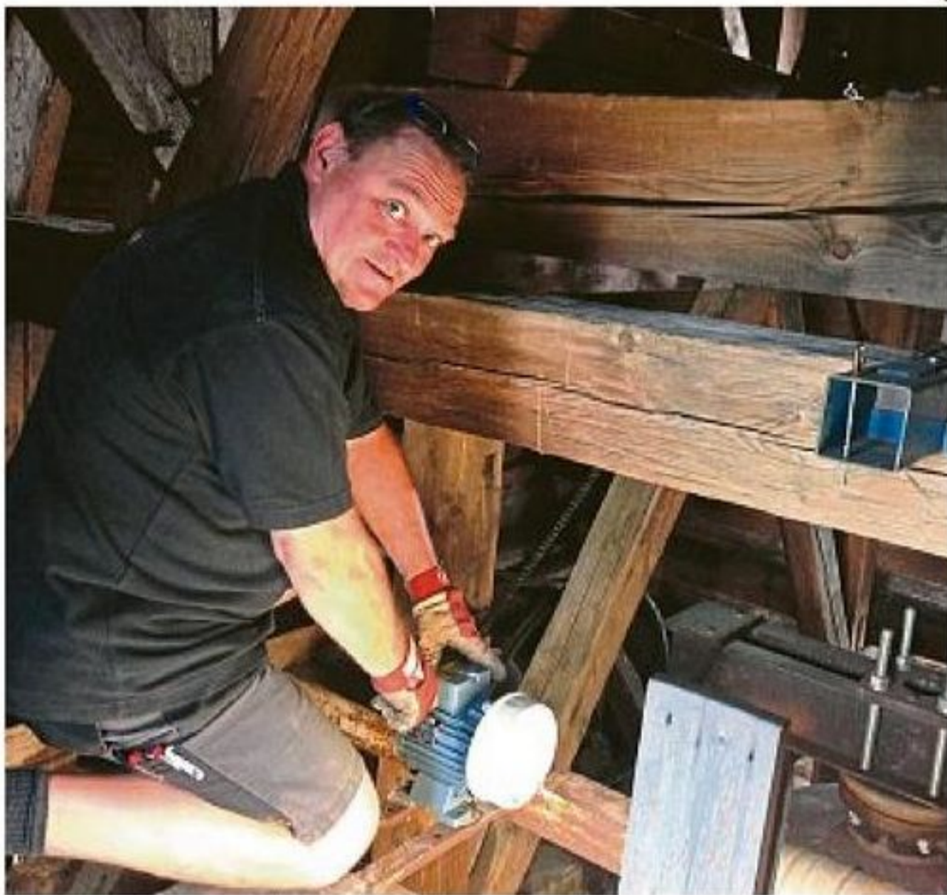
Josef Saller repariert die Kirchturmuhre, hat gerade einen Glocken-Antriebsmotor ausgewechselt. Fotos: RH
